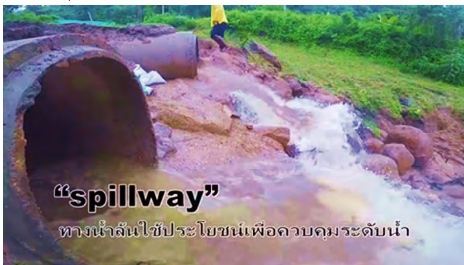
ภาพที่ ๓.๑๔ ทางน้ำล้น ใช้สำหรับควบคุมระดับน้ำ
